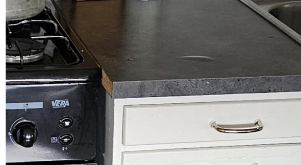
Mangler kant laminering på benkeplate og boble i benkeplate.
