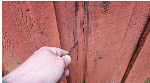
Råteskadet kledning.
