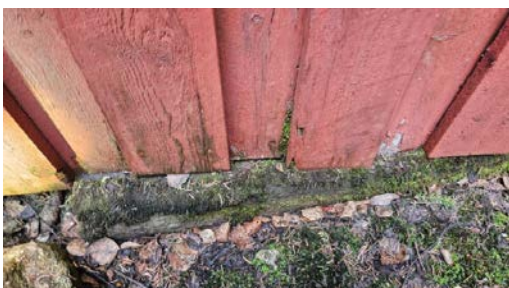
Bordkledning som går helt ned i terreng.
