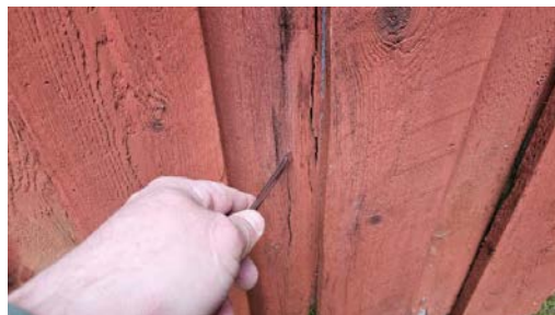
Råteskadet kledning.
