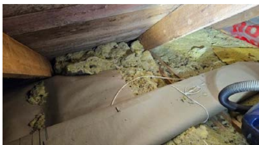
Spor av mus og røyskatt, isolasjonen bærer preg på at de har vært der en stund.
