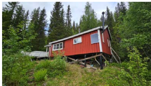
Bjelkelag med stubblofts konstruksjon.
