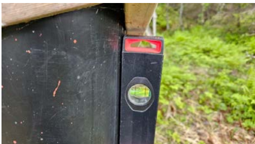
Skjevheter i pilarer.
