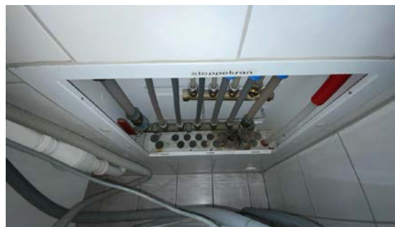
Besiktigelse av røropplegg.
