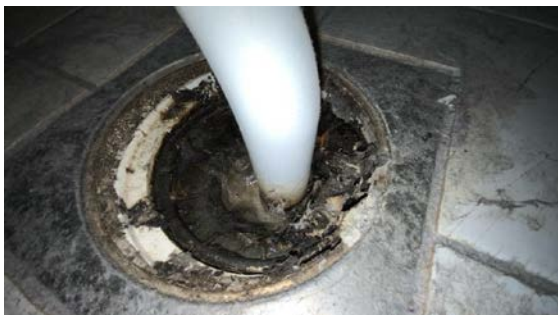
Kontroll av sluk.
