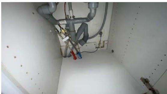
Besiktigelse av røropplegg.
