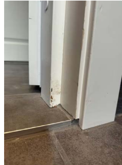
Noe slitasje på dørkarm.
