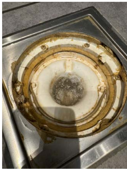
Sluk med membran under klemring.
