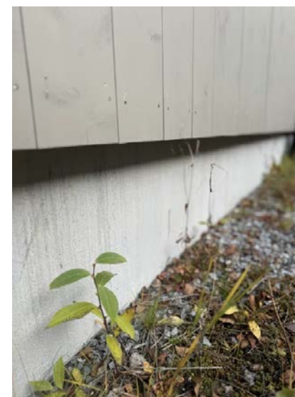
Ingen vesentlige skader på mur.
