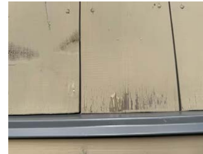
Det er ikke stor nok dryppkant på panel ned mot beslag, det bør være ca 8mm fra bordene til beslag.
