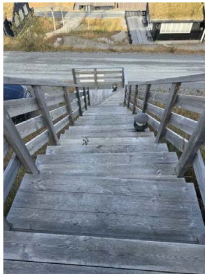
Trapp i terreng til innkjørsel.
