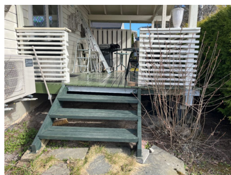
Trapp til veranda.
