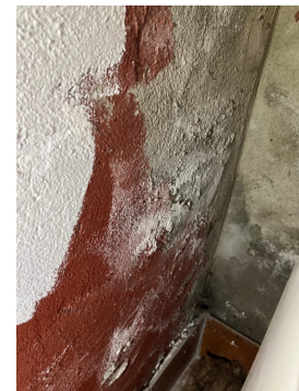
Fuktmåling i utforet vegg viste skadelig fukt.
