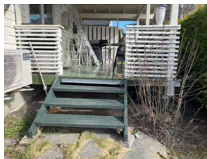
Trapp til veranda.
