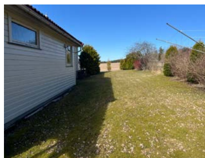
Terrenget heller mot bygning fra øst.
