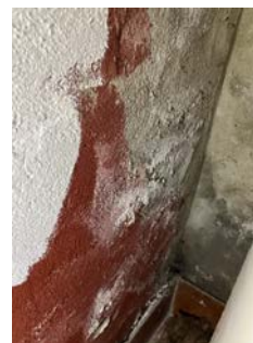
Fuktmåling i utforet vegg viste skadelig fukt.
