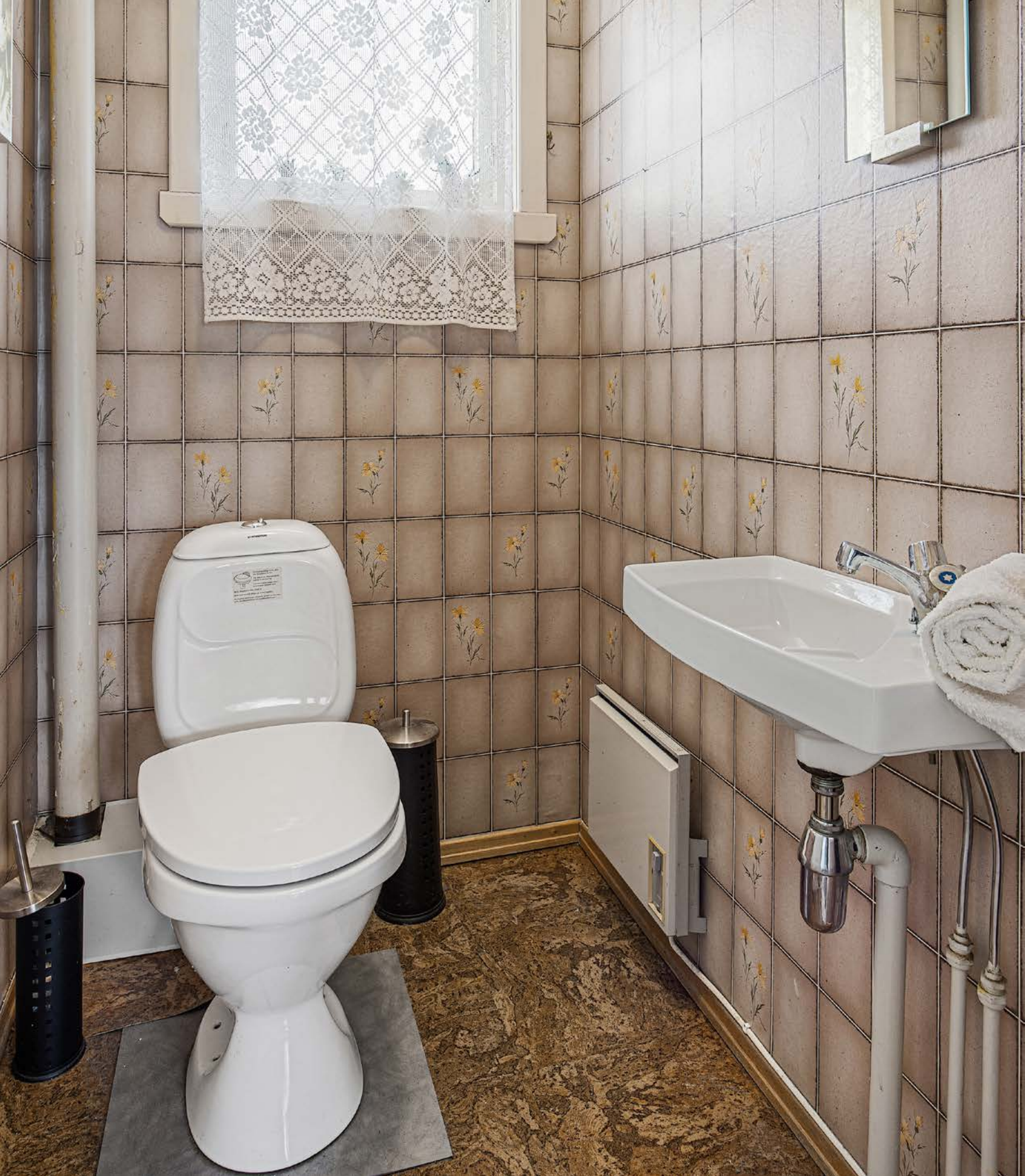
Wc-rommet er innredet med vinylfliser på gulvet og våtromstapet på veggene.
