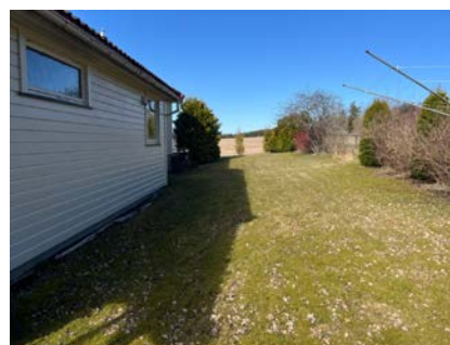
Terrenget heller mot bygning fra øst.
