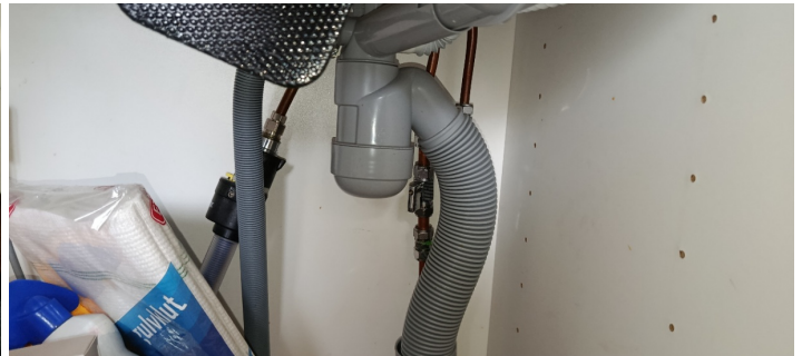
Kontroll av røropplegg.
