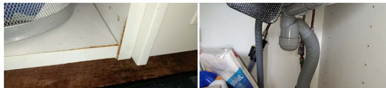
Kontroll av røropplegg.
