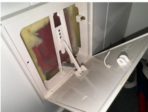
Eksempel på påvist bruk av dampsperre
