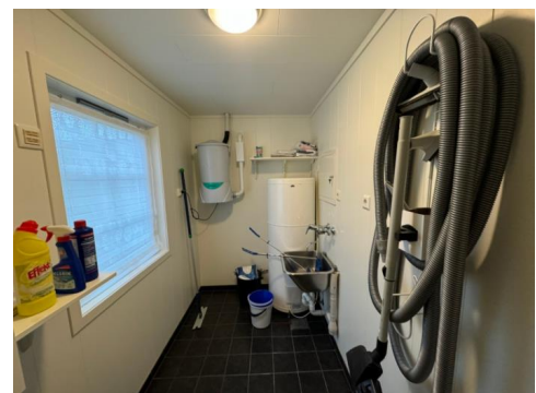
Overflater av malte plater.
