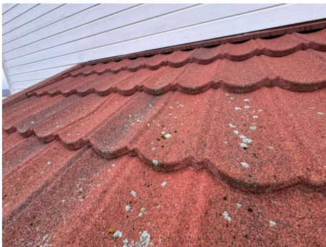
Eksempel på bulk i taktekingen.
