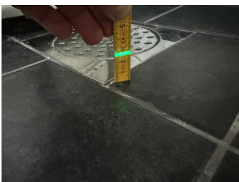
Måling ved sluk.
