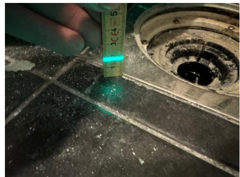
Måling ved sluk.
