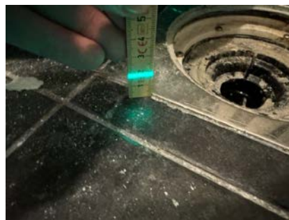
Måling ved sluk.
