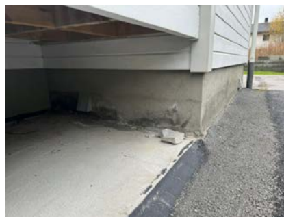
Krypekjeller under utvendig bod.
