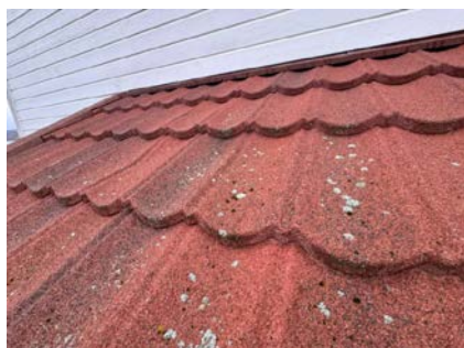
Eksempel på bulk i taktekingen.
