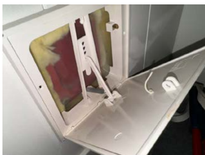
Eksempel på påvist bruk av dampsperre
