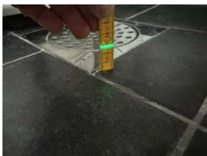
Måling ved sluk.
