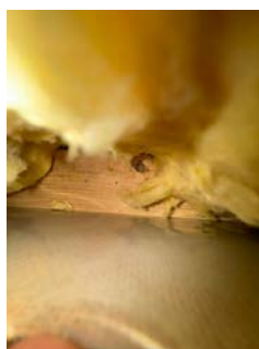
innvendig i veggen hvor fuktmålingen er foretatt
