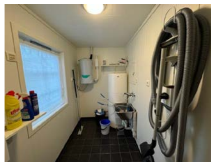
Overflater av malte plater.
