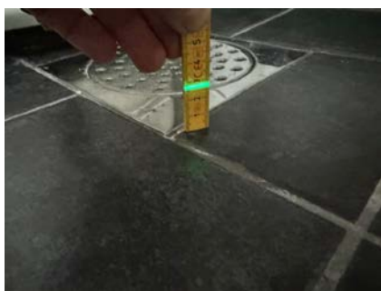
Måling ved sluk.
