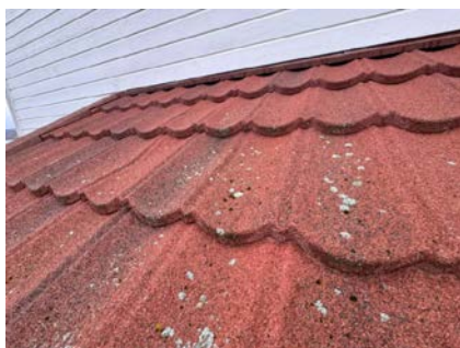
Eksempel på bulk i taktekingen.
