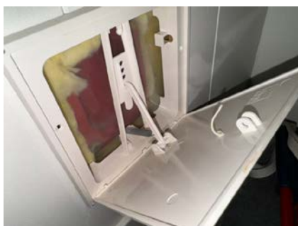
Eksempel på påvist bruk av dampsperre
