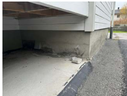
Krypkjeller under utvendig bod.
