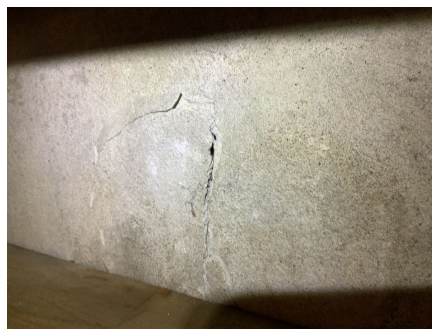
Eksempel på innvendig skråriss.
