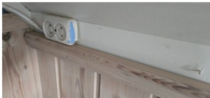
Bilde 2 Hull i lokk soverom 2 etasje.
