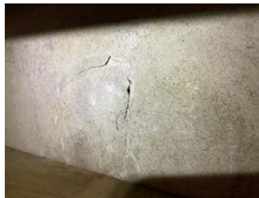
Eksempel på innvendig skråriss.
