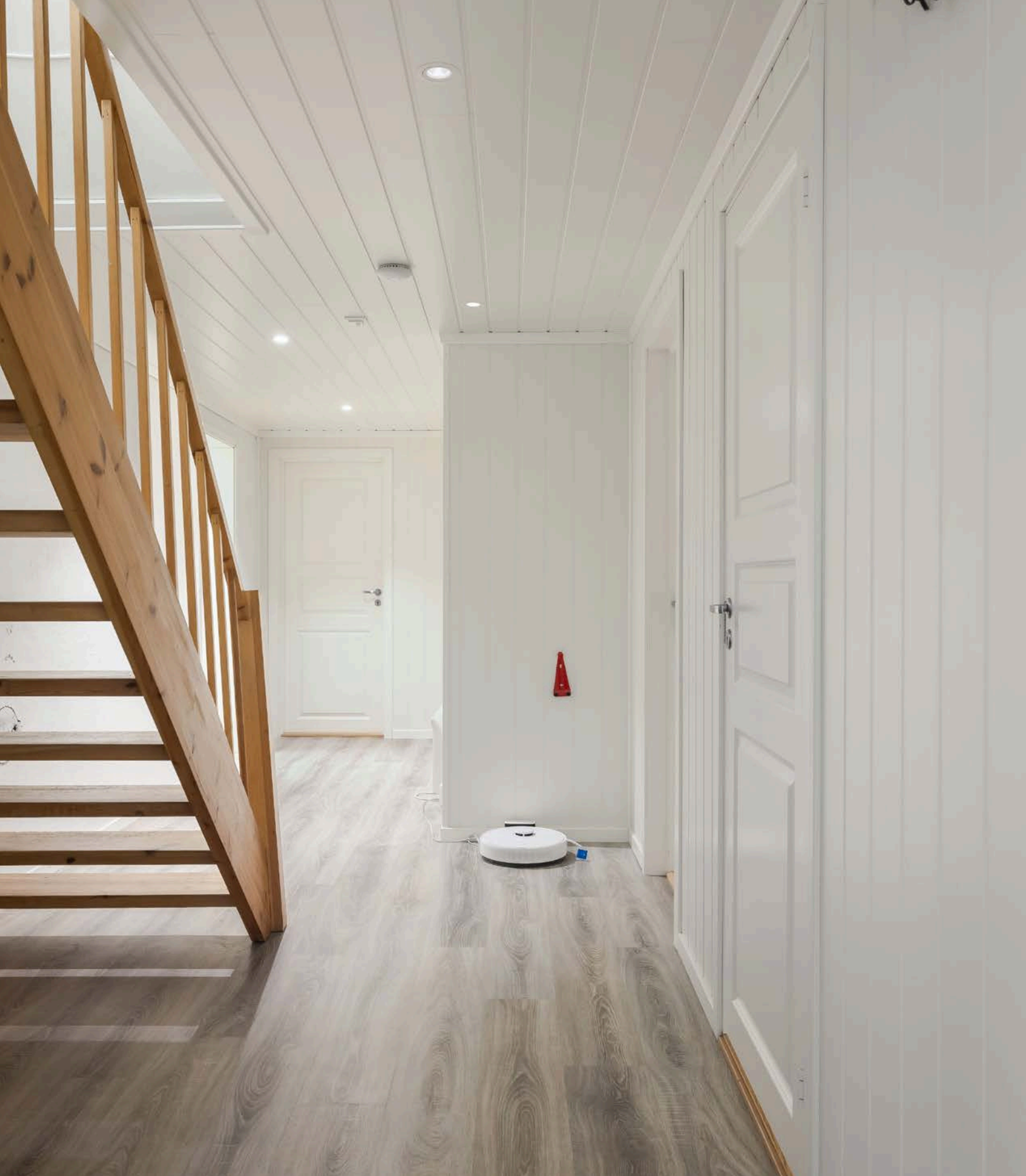
Gang/trapperom i kjeller med innfelte downlights i himlingen. Hele kjelleretasjen er innredet i 2017, men ikke søkt bruksendret og er derfor ikke godkjent for varig opphold.
