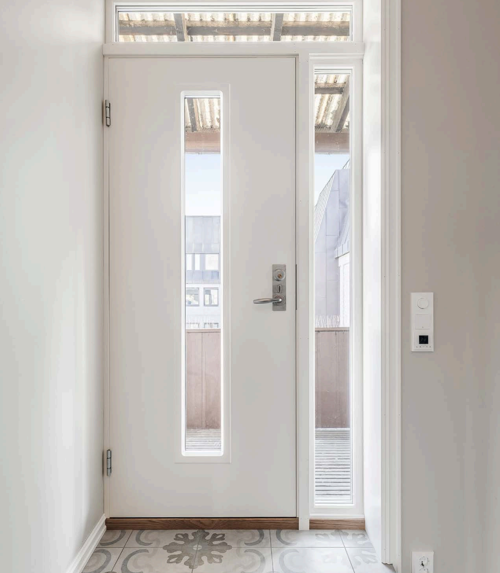
Inngangspartiet er flislagt med varmekabler
