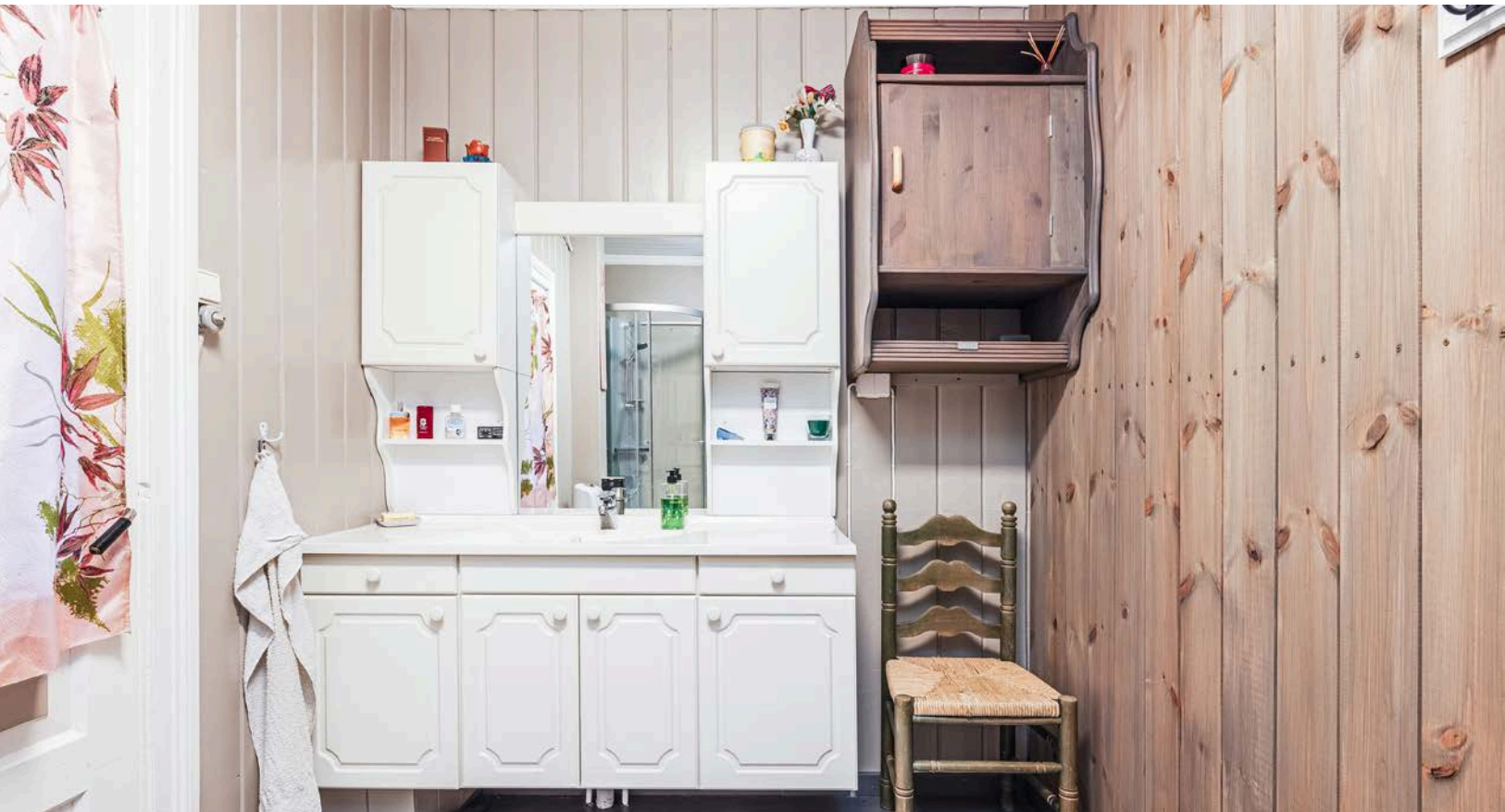
Eldre badrom i 1. etasje med malt tregulv og trepanel på veggene. Badrommet har fått TG3 og har behov for oppussing.
