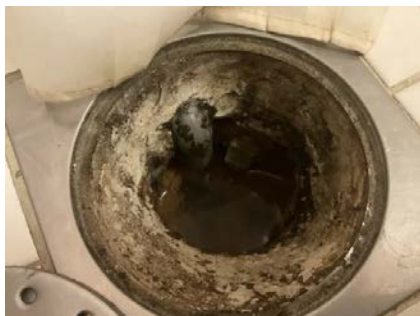
Ikke synlig mansjett i klemring.
