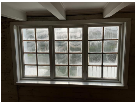
Punkttert stuevindu. Vindu i trekarmen med koblet glass.
