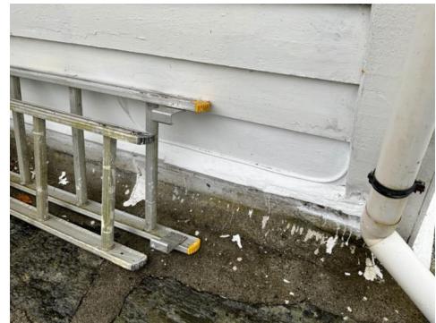
Overgang grunnmur/ kledning.
