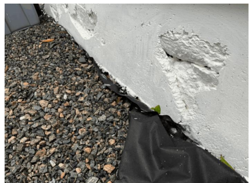
Grunnmuren har nylig vært malt i forbindelse med maling av huset.
