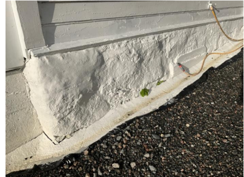
Overgang grunnmur/ kledning.
