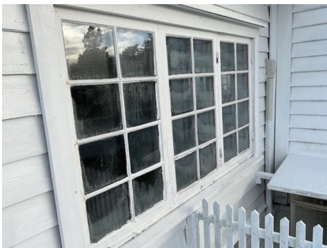
Punkttert stuevindu. Vindu i trekarmen med koblet glass.
