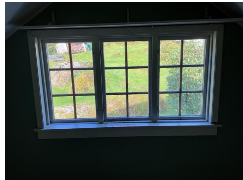
Vinduer med koblet glass, loftsetasje.
