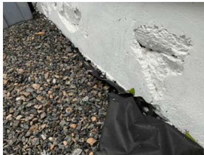
Grunnmuren har nylig vært malt i forbindelse med maling av huset.
