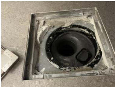
Kontroll av sluk under servant.
