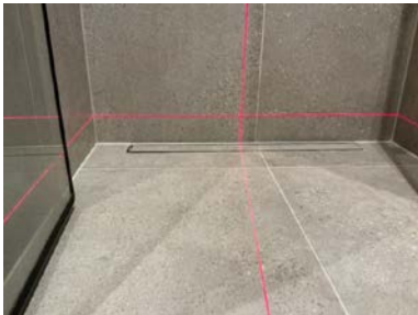
Fall på baderomsgulv er kontrollert med krysslaser.
