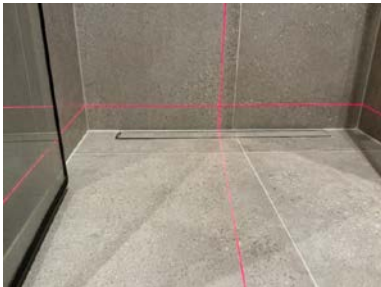
Fall på baderomsgulv er kontrollert med krysslaser.
