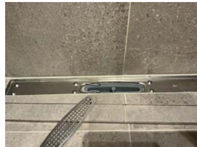
Kontroll av slukrenne i dusj.
