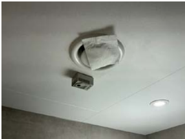
Kontroll av avtrekk.
