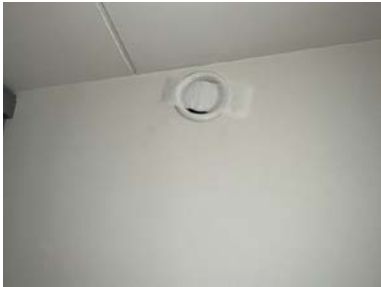
Kontroll av avtrekk.
