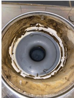
Sluk med synlig membran og klemring.
