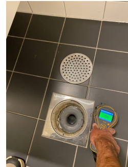
Sluk med synlig membran og klemring.
