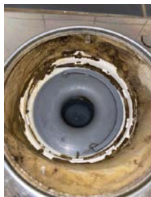
Sluk med synlig membran og klemring.
