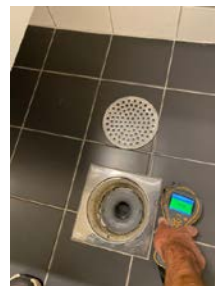
Sluk med synlig membran og klemring.
