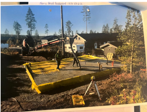
Radonsperre under påstøp. Eiers bilde.
