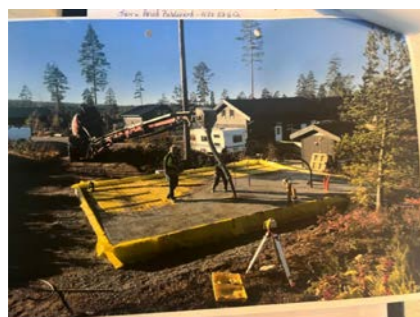
Radonsperre under påstøp. Eiers bilde.
