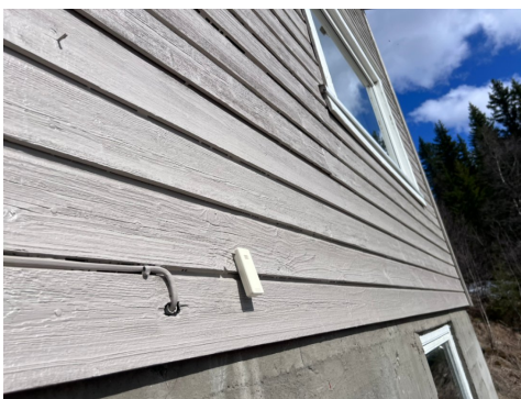
Vegger fra byggeår/tilbygd år, men foretatt utvendig vedlikehold
