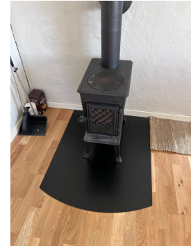
Skiftet ildsted og foretatt piperehab
