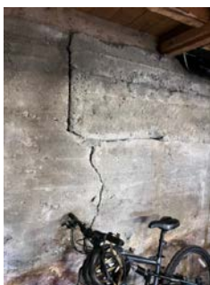
Sprekker og deformasjoner på mur
