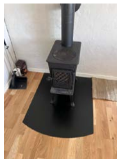
Skiftet ildsted og foretatt piperehab
