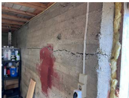
Sprekker og deformasjoner på mur
