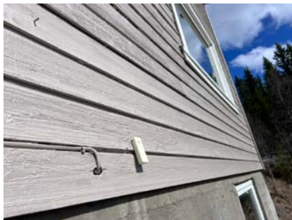
Vegger fra byggeår/tilbygd år, men foretatt utvendig vedlikehold
