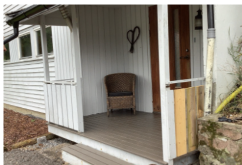
takoverbygget platting ved inngang i underetasjen
