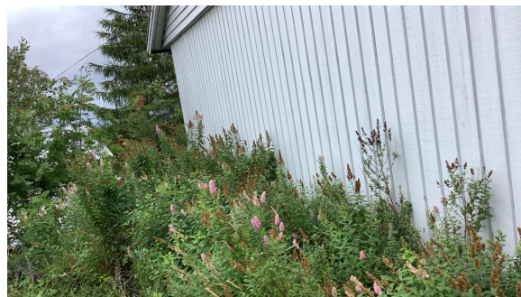
Beplantning inntil yttervegg.
