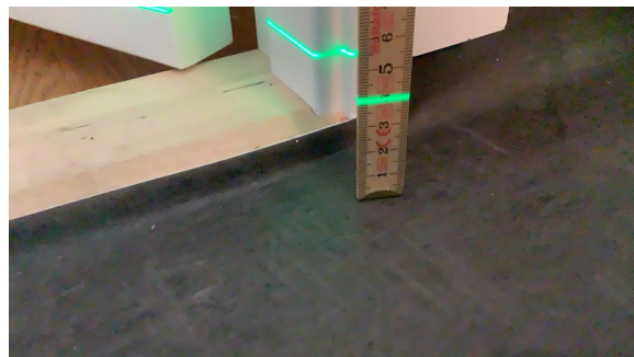
Det er oppkant av belegg mot dør
