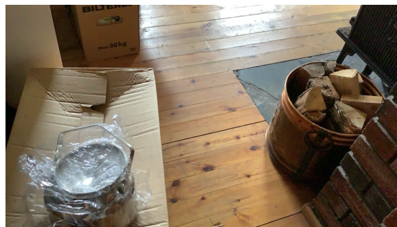
Oppforet tregulv i deler av underetasjen.
