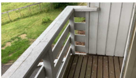
Balkong i 1. etasje.
