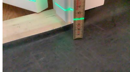
Det er oppkant av belegg mot dør
