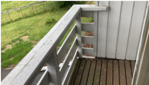
Balkong i 1. etasje.
