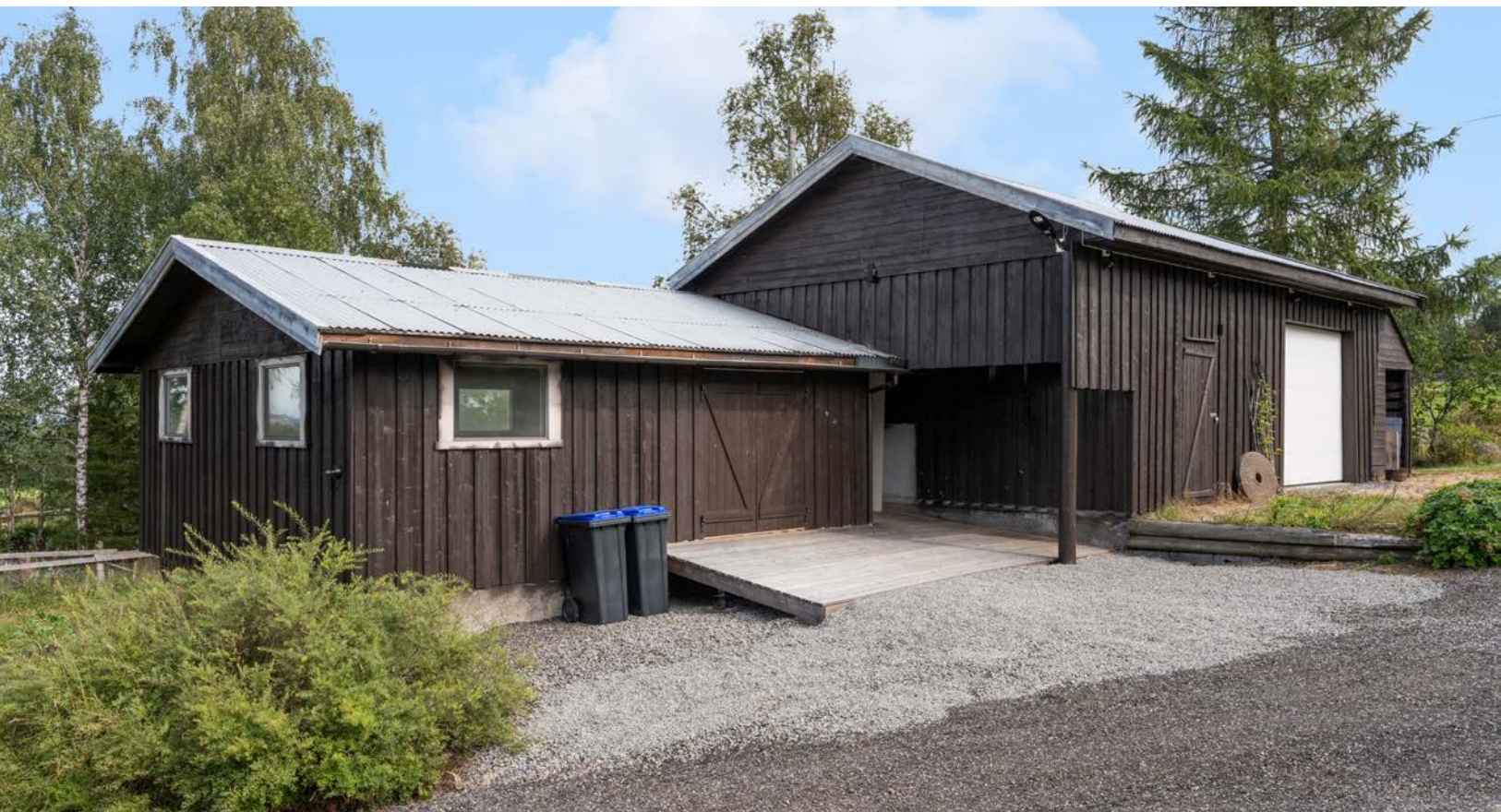
Uthus på eiendommen.
