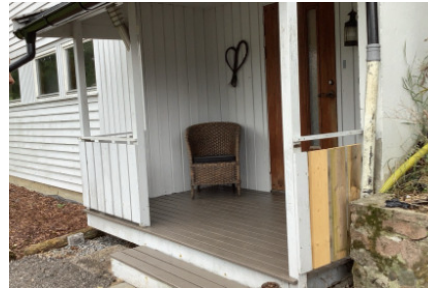
takoverbygget platting ved inngang i underetasjen
