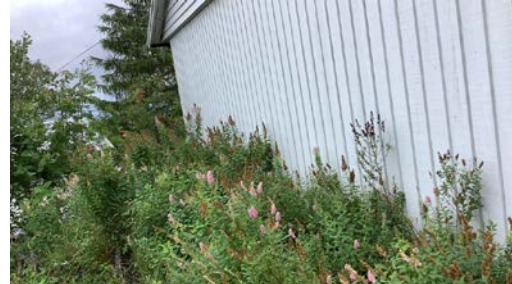
Beplantning inntil yttervegg.
