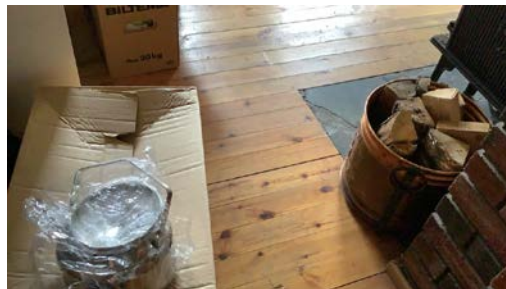
Oppforet tregulv i deler av underetasjen.
