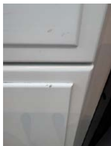
Enkelte småskader/hakk i innredningen
