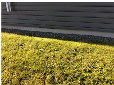
Grunnmuren er kledd med plater.
