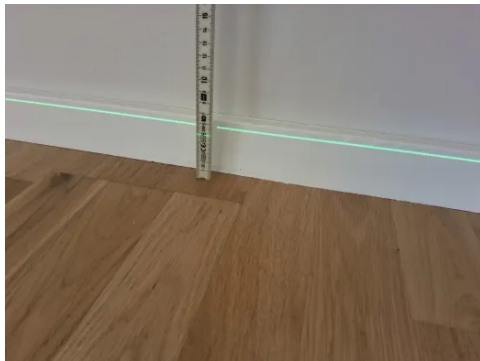
Etasjeskillet er kontrollert med nivelleringslaser.
