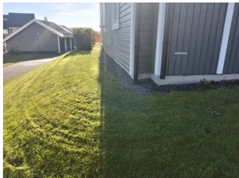
Nedløpsrør er avsluttet over terreng.
