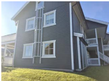
Boligen er kledd med stående og liggende trekledning.
