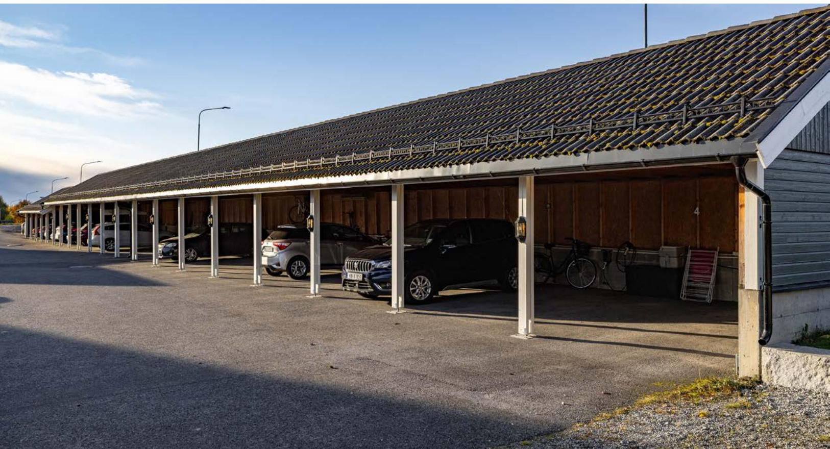
Parkering i felles rekke med carport følger leiligheten.
