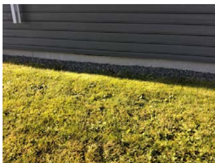
Grunnmuren er kledd med plater.
