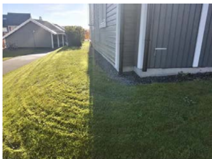
Nedløpsrør er avsluttet over terreng.
