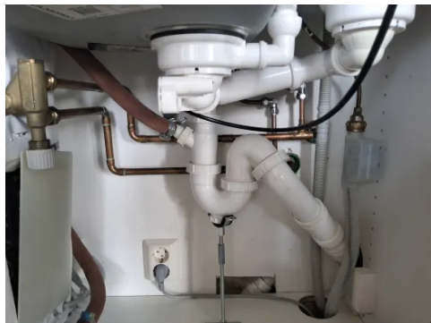
Synlige avløpsrør av plast.
