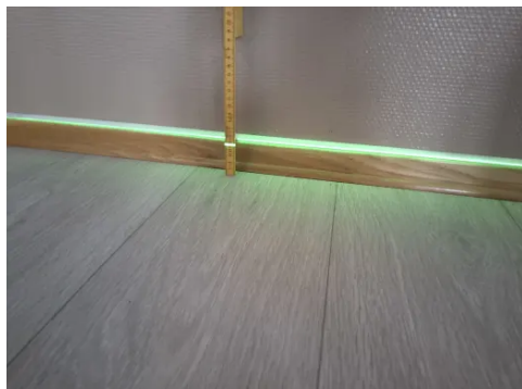
Etasjeskillet er kontrollert med nivelleringslaser.
