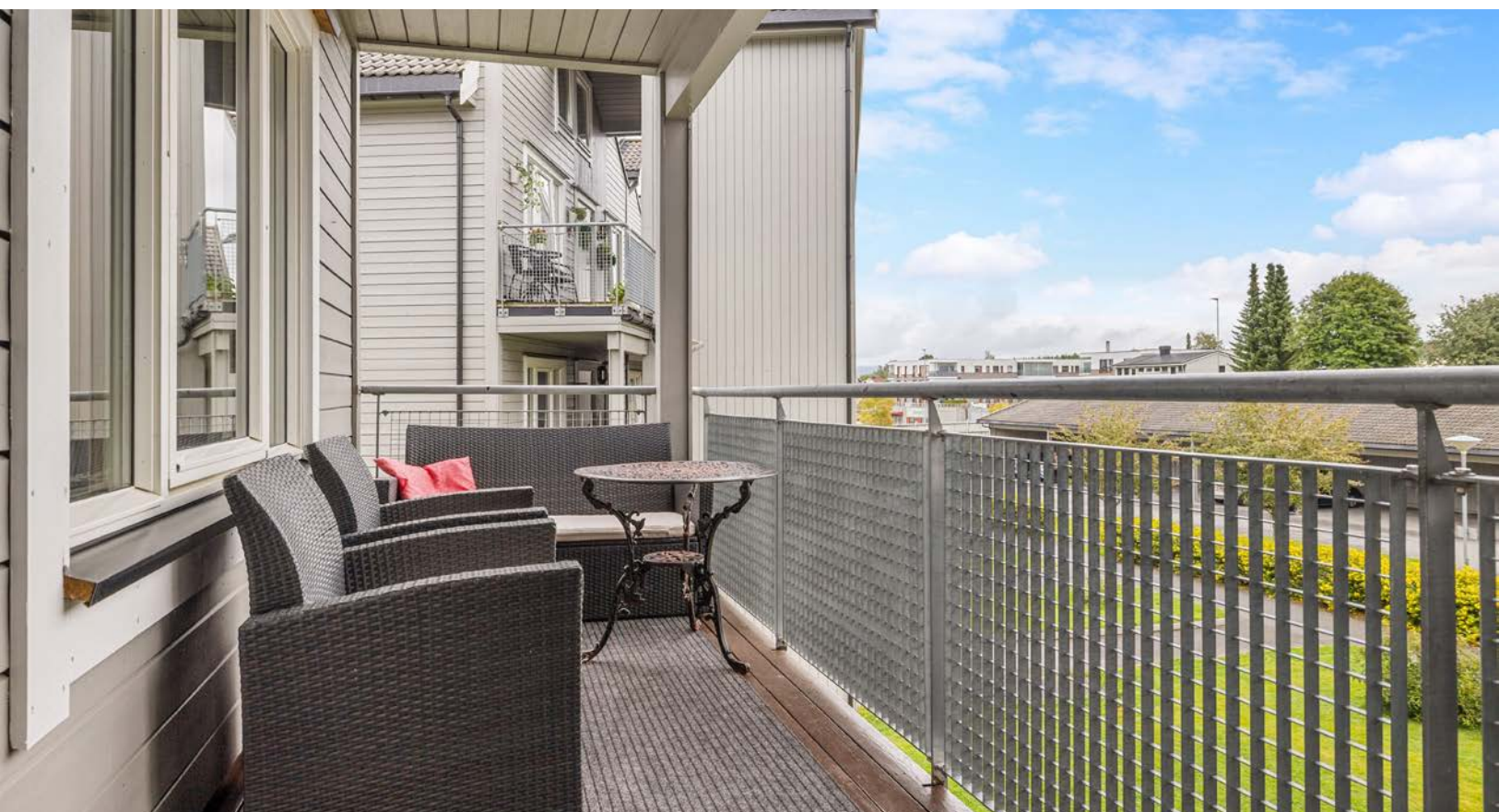
Ved inngangspartiet er det en østvendt balkong.
