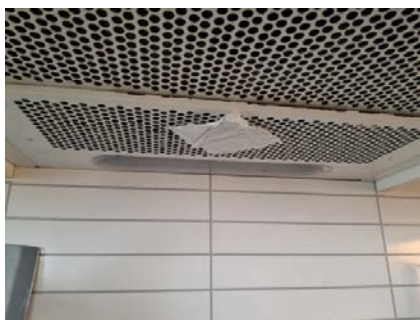
Avtrekkseffekt er testet med papir.
