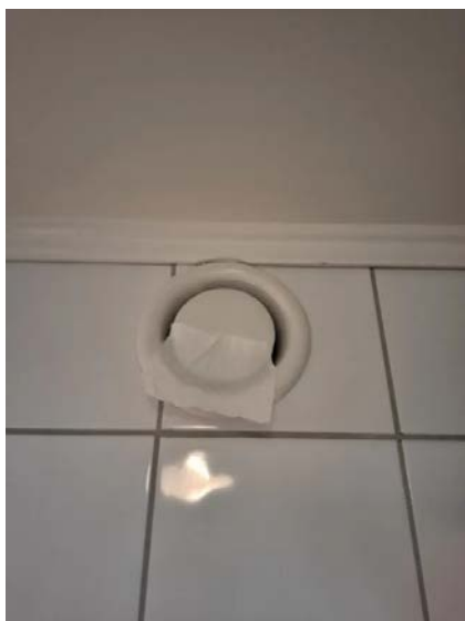
Avtrekkseffekten er testet med papir.
