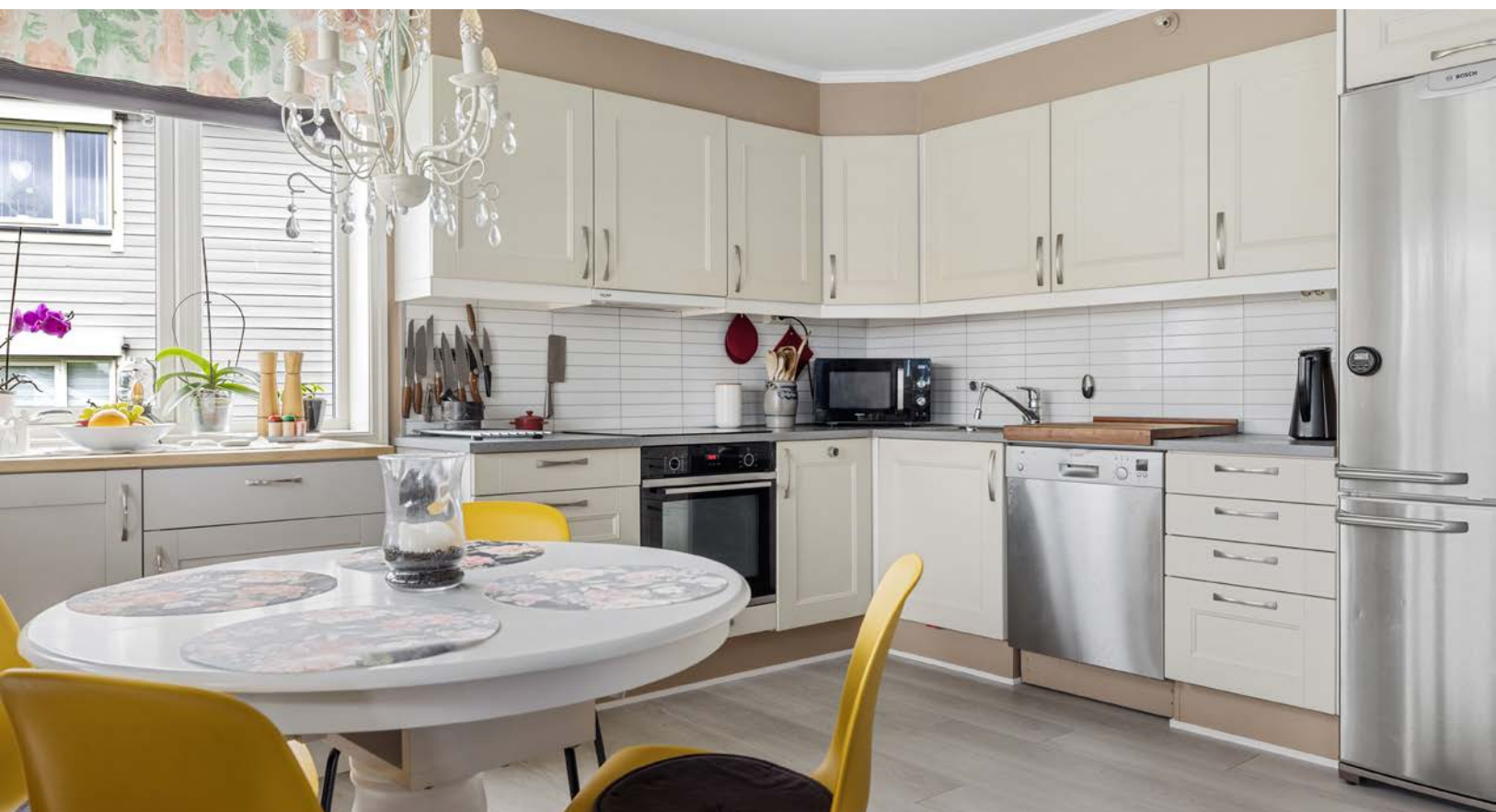
Laminert benkeplate med oppvaskkum i rustfritt stål. I benkeryggen er det laminatplate for enkel rengjøring. Stekeovn og platetopp er integrert, mens det er plass for frittstående oppvaskmaskin kjøleskap.
