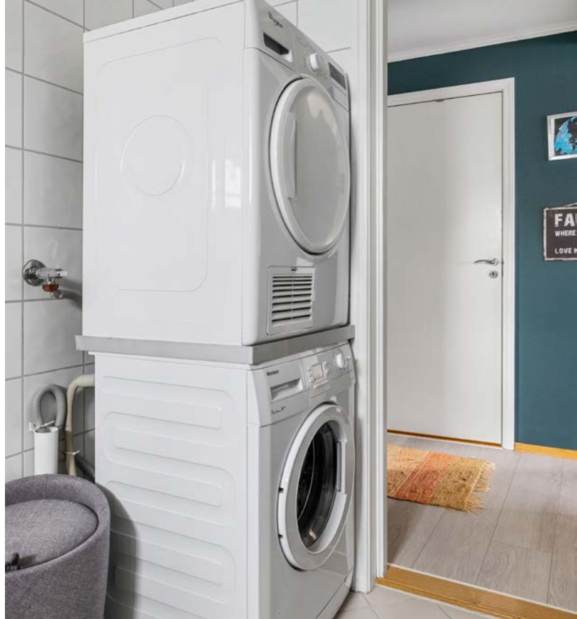
Det er opplegg for vaskemaskin og tørketrommel.
