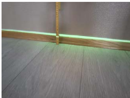
Etasjeskillet er kontrollert med nivelleringslaser.
