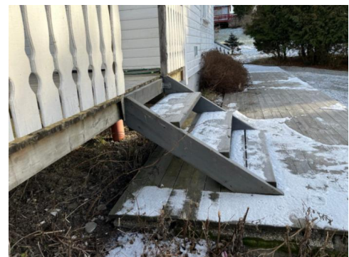
Manglene rekkverk
