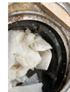
Manglende membran i gulv/sluk.
