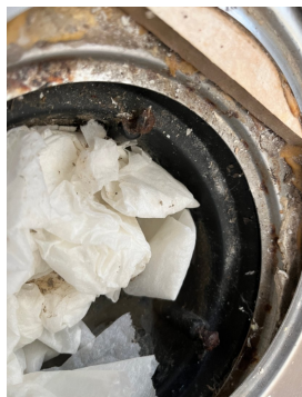
Manglende membran i gulv/sluk.
