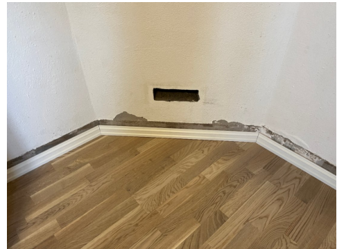
Pipe tildekket i 1.etg.
