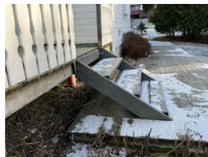
Manglene rekkverk
