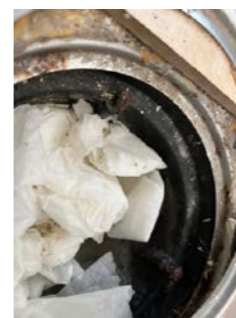
Manglende membran i gulv/sluk.
