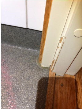
Bilde av fuktskade på dørkarm og foring
