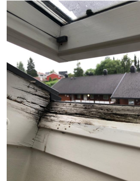
Bilde av råteskader på takvindu
