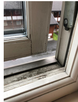
Bilde av råteskader på takvindu
