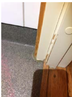
Bilde av fuktskade på dørkarm og foring
