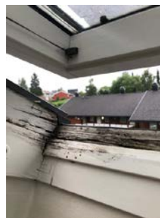
Bilde av råteskader på takvindu
