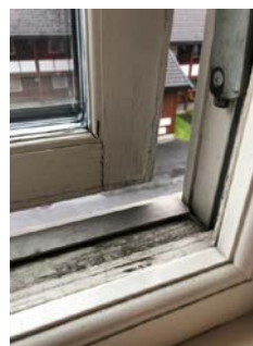
Bilde av råteskader på takvindu
