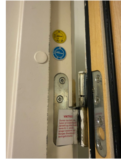
Eentrédør med brannklasse B30 og lydklasse db40.
