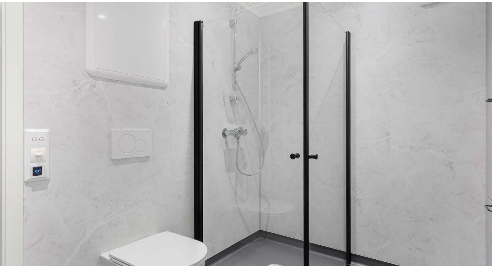
Alle våtrommene har gulvvarme og mekanisk avtrekk.
