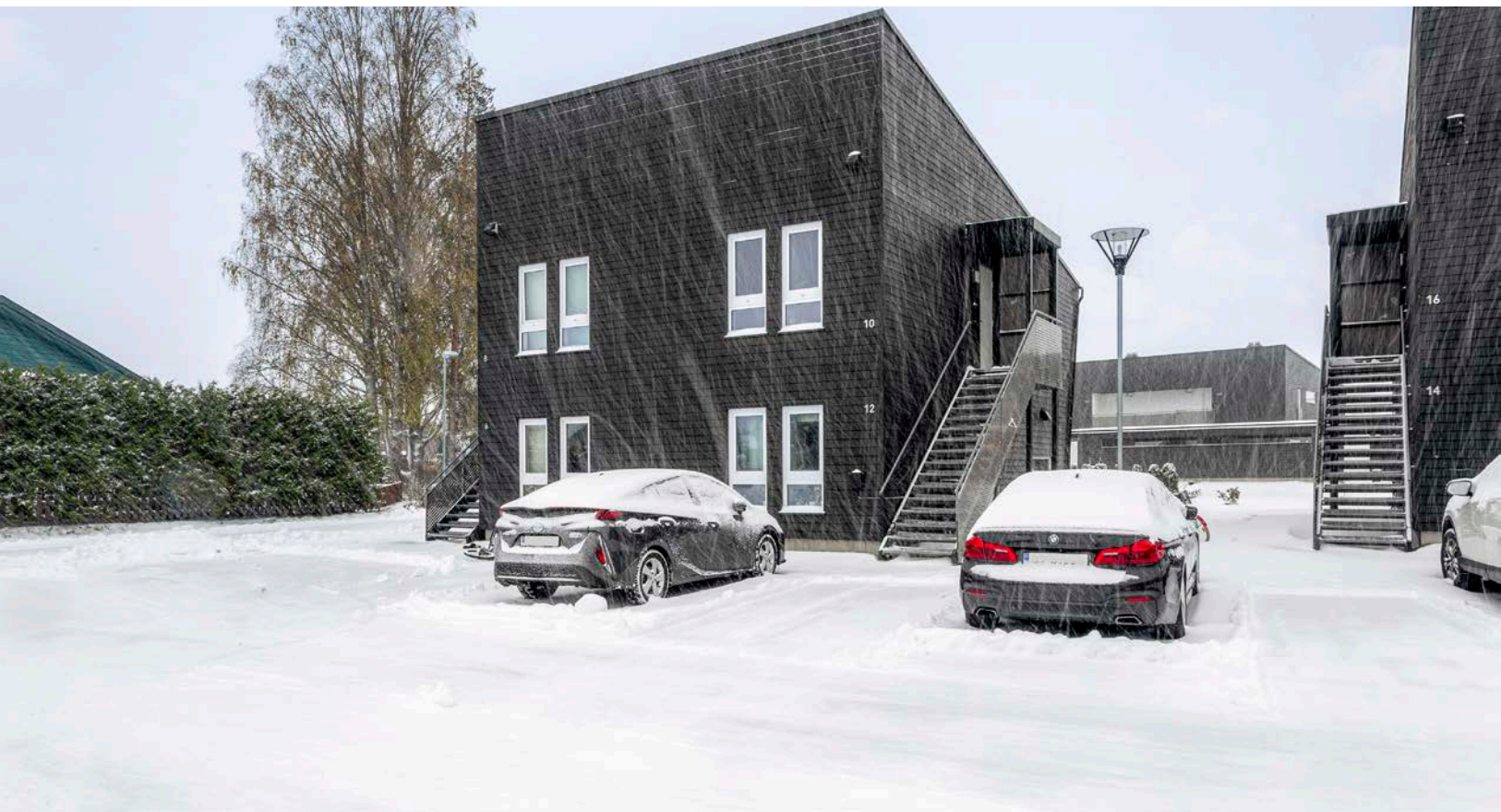
Fasade. Det er adkomst til leiligheten via utvendig trapp.
