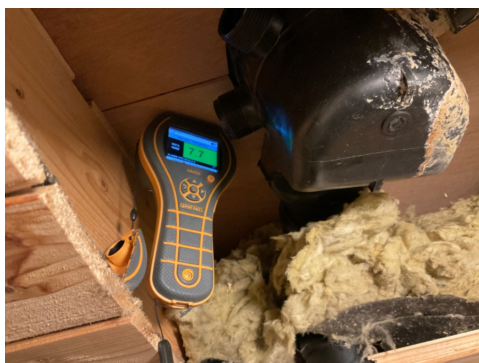
Fuktmåling baderom 12. etasje
