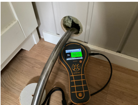
Hulltaking i utformet kjellervegg
