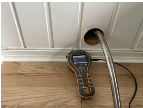
Hulltaking mot vaskerom
