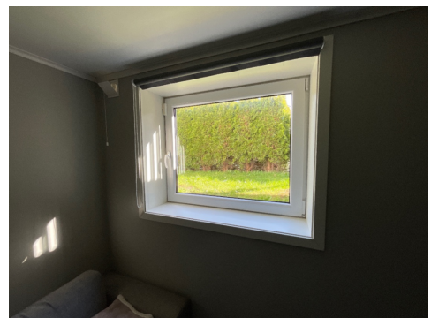
Pvc vindu i kjeller
