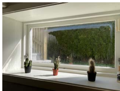
Baderomsvindi i kjeller
