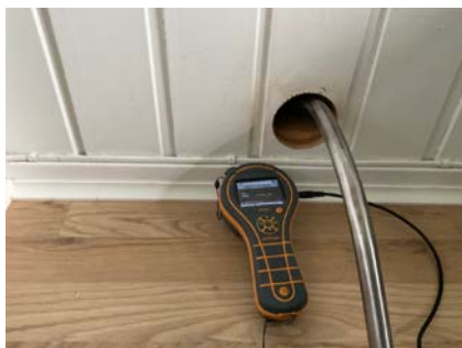
Hulltaking mot vaskerom
