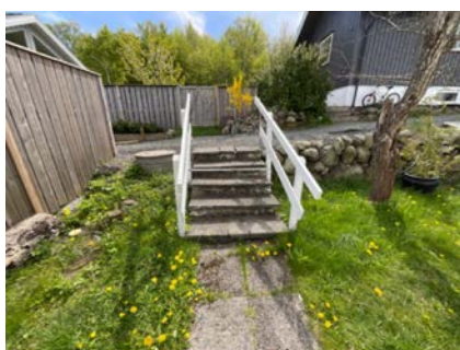
Trapp bygget med heller
