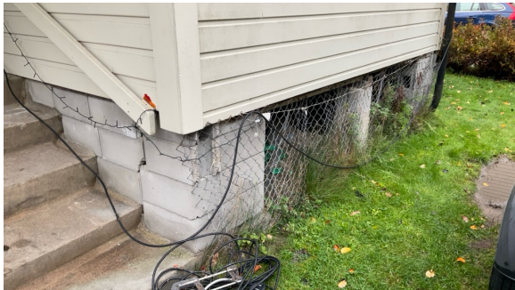
Grunnmur ved inngangsparti i blokker.
