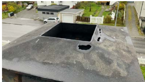
Hull i topphatt på pipen
