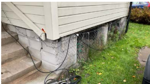
Grunnmur ved inngangsparti i blokker.
