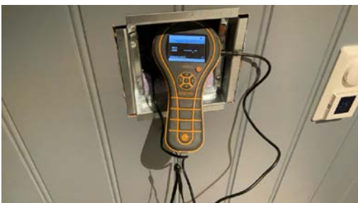
Fuktmåling med pigger i treverk.
