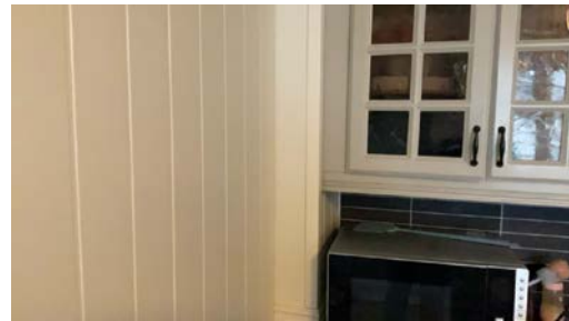
Pipe er kledd inn med plater på kjøkken.
