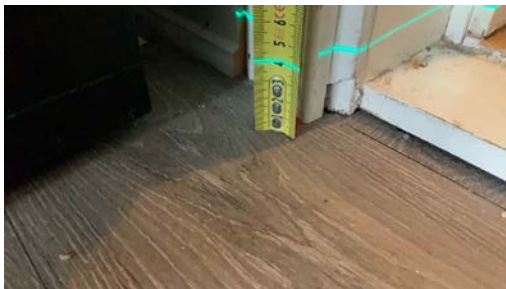
Høyde ved dør til gang. 0-punkt er ved dør til vinterhage.
